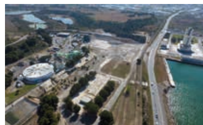
Site industriel de Lafarge à Frontignan (34) © Sète Agglopôle Méditerranée
