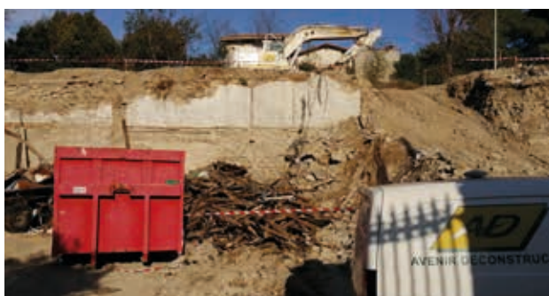
Tri des déchets en tas à Caveirac (30) - © EPF d'Occitanie
