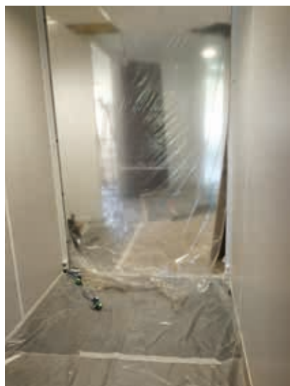
Locaux antenne de Toulouse © EPF d'Occitanie
