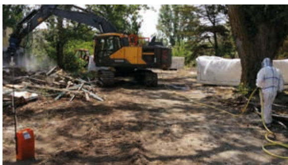
Tri des matériaux amiantés à la pelle à Caveirac (30) © EPF d'Occitanie
