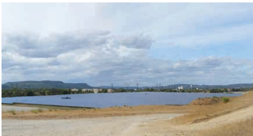
Site Arcelor Mittal à Laudun L'Ardoise (30) - © EPF d'Occitanie
