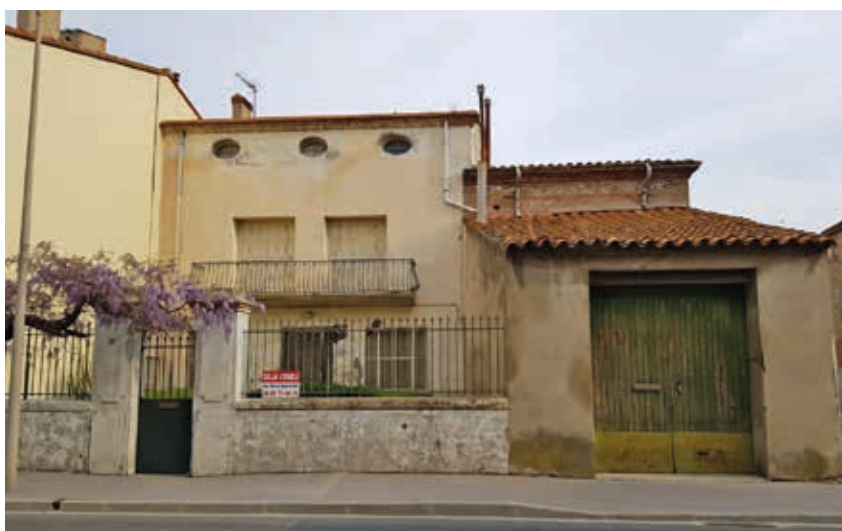
Préemption d'une ancienne maison de maître à Sainte-Marie-de-la-Mer (66) en avril 2019 en vue de la réalisation d'un projet de 8 logements locatifs sociaux - © EPF d'Occitanie
