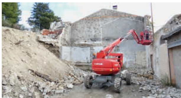
Démolition manuelle à Caveirac (30) - © EPF d'Occitanie
