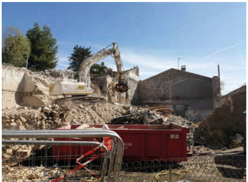
Travaux Caveirac (c) - © EPF d'Occitanie
