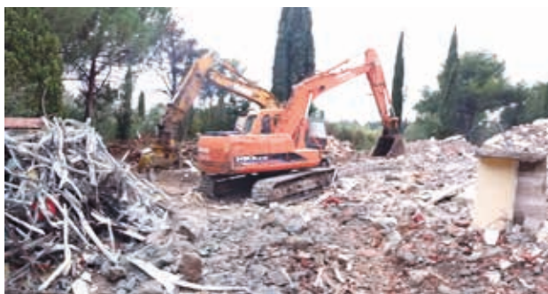
Pince de broyage de béton à Montpellier (34) - © EPF d'Occitanie
