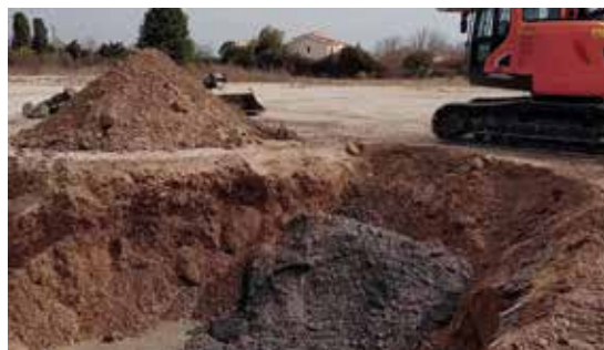
Réalisation des travaux complémentaires d'élimination de sources de pollution d'hydrocarbure dans les sols. - © EPF d'Occitanie
