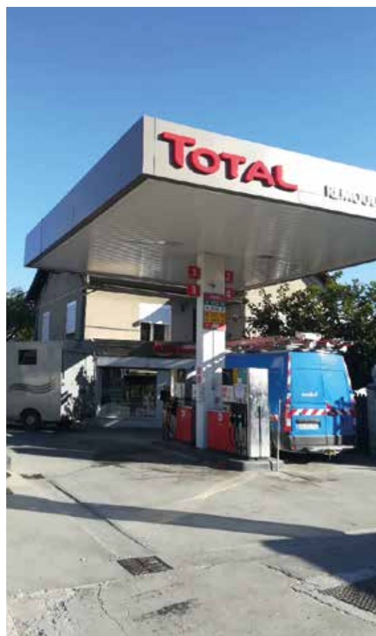
Station-service et son annexe acquise par l'EPF dans le cadre du projet - Remoulins. © EPF d'Occitanie
