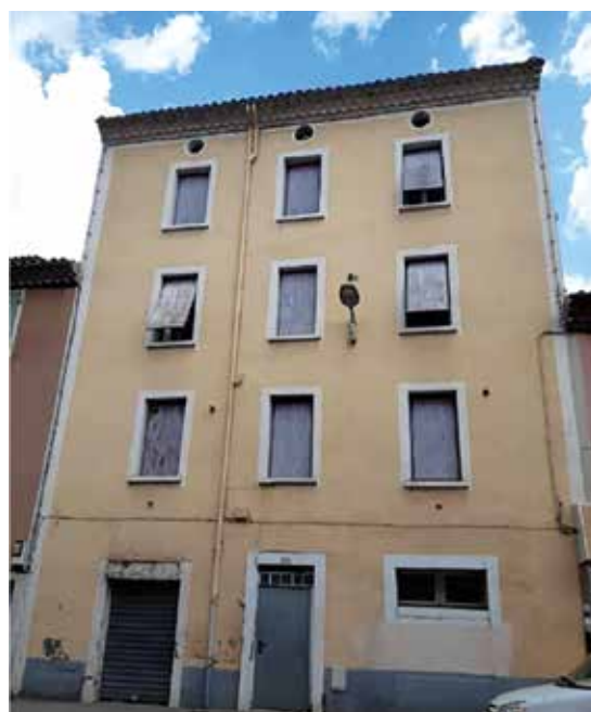
Immeuble acquis par l'EPF dans le cadre du projet de renouvellement urbain à Alès. © EPF d'Occitanie
