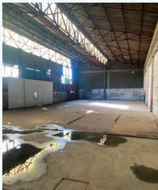
Boulangerie industrielle en friche destinée à la réalisation d'un tiers-lieu - Millas. © EPF d'Occitanie
