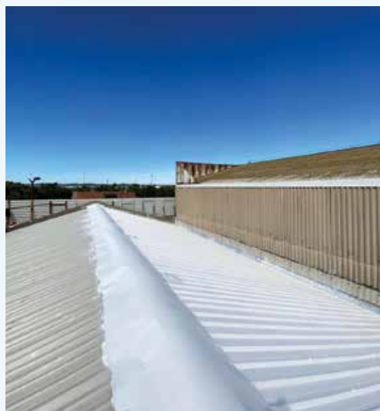
Travaux de toiture d'un local commercial - Sète © EPF d'Occitanie
