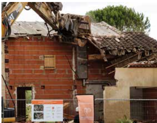
Démolition d'un bien sinistré lors des inondations d'octobre 2018 - Couffoulens. © G. Lefrancq - EPF d'Occitanie
